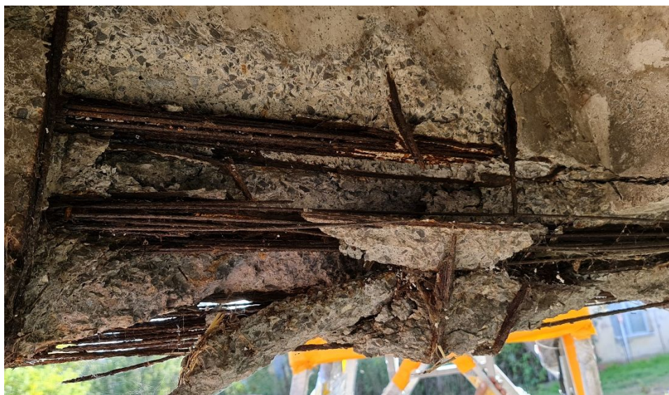
Obrázok 33 - Vzorový príklad miery poškodenia spodnej príruby nosníka
